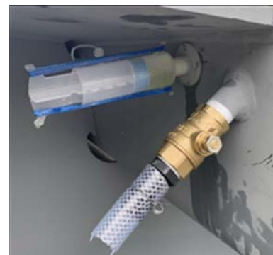
図-6 エポキシ樹脂の 2 次注入施工状況
