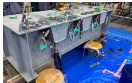
図-2 樹脂モルタルの充填状況
