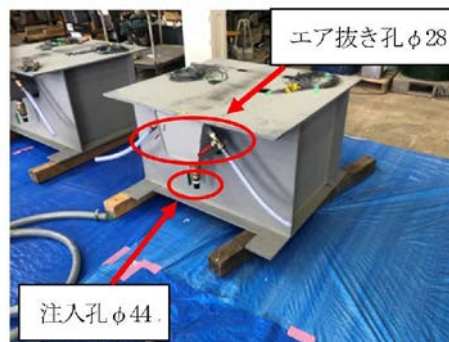
図-3 樹脂モルタル充填孔
