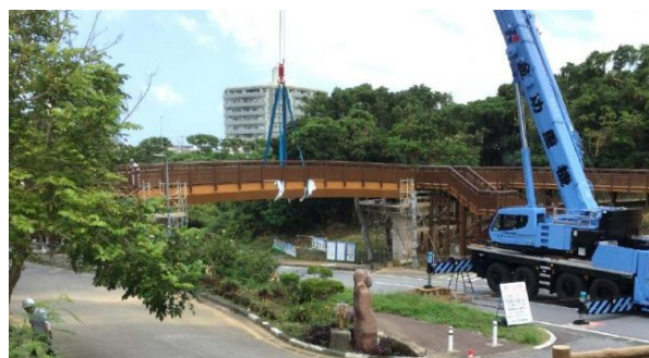
図-1 浦添公園歩道橋
