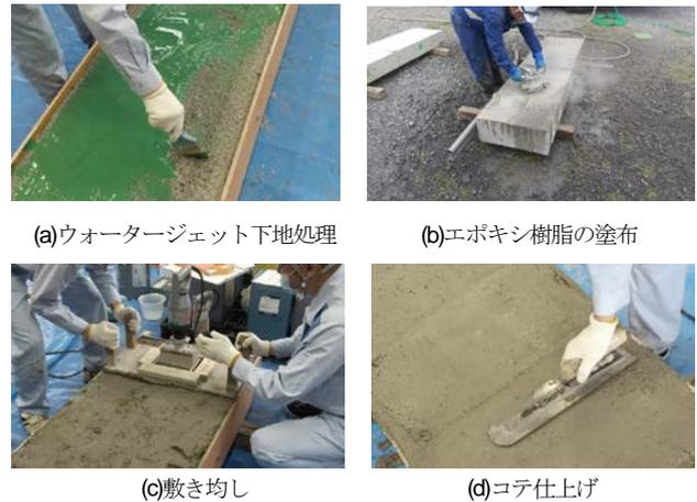
図-3 下地処理, 樹脂の塗布, 敷き均し, コテ仕上げ
