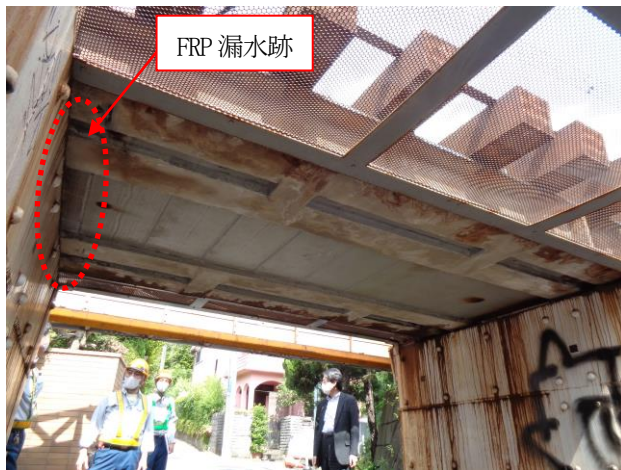
(a) 上り線桁下面（複合構造化後9年経過）
