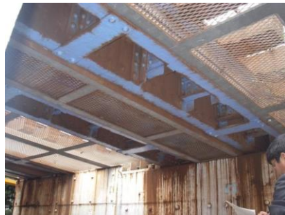
(c) 下り線桁下面（複合構造化前）
