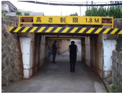
(a) 川島陸橋全景
