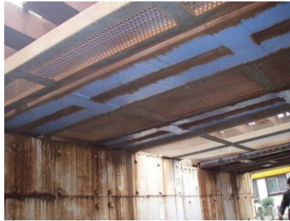
(b) 上り線桁下面（複合構造化前）
