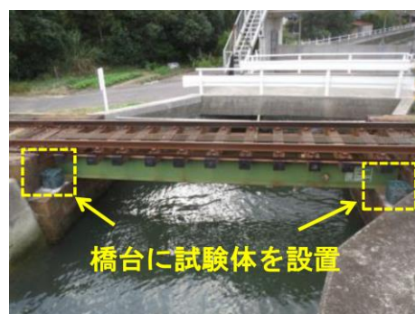
写真-4 高松琴平電鉄原川橋梁（単純Iビーム）
