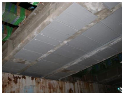
(e) 下り線桁下面（複合構造化後）
