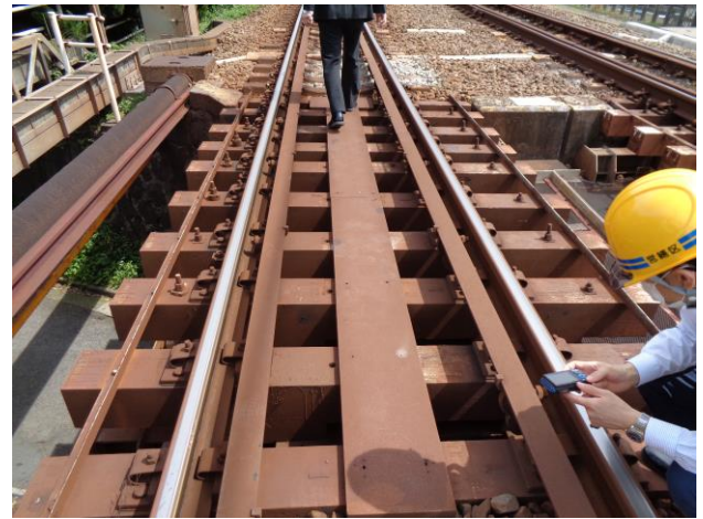
(a) 上り線桁上面（複合構造化後9年経過）
