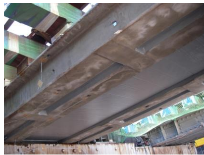
(d) 上り線桁下面（複合構造化後）
