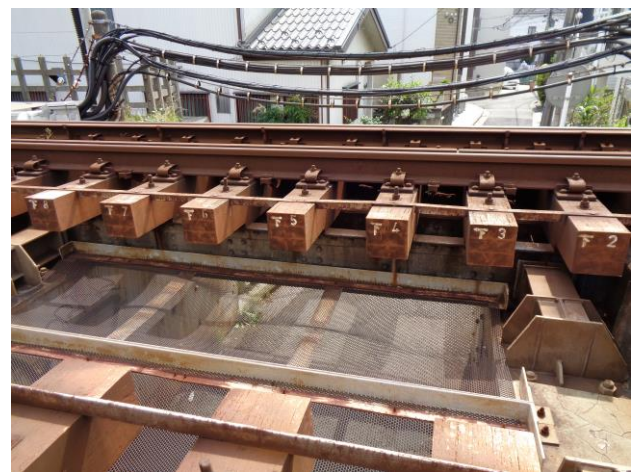
(b) 下り線桁側面（複合構造化後9年経過）
