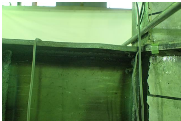
(b) (a) の上フランジ部拡大 写真-2 既往の実験 3) 載荷後の状況一例
