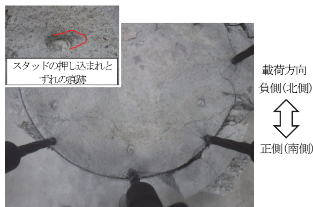
写真-4 せん断供試体 載荷終了後の杭体南側上面の状況
