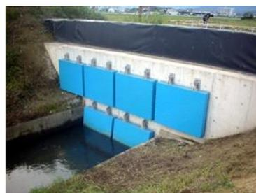
図-1 FRPフラップゲートの施工例
