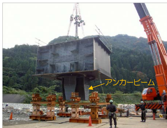
写真-2 中間支点部に用いたアンカービーム事例
