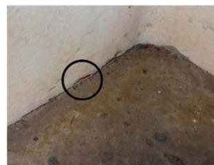
写真-2 鋼柱基部とフーチングの隙間及び塗膜の剥がれの状況
