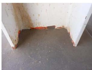
写真-1 鋼柱基部の塗膜の剥がれの例
