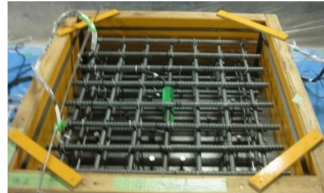
写真-1 Type-4 の供試体製作状況
