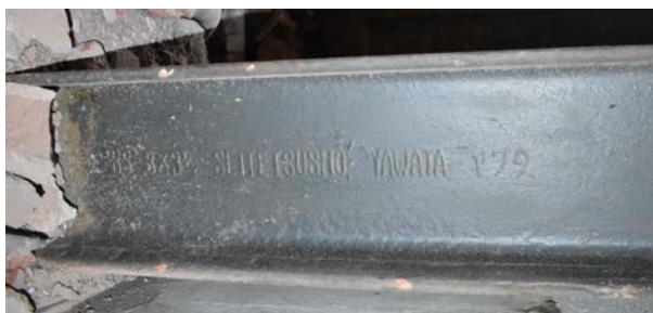
写真-3 内柱のロールマーク
