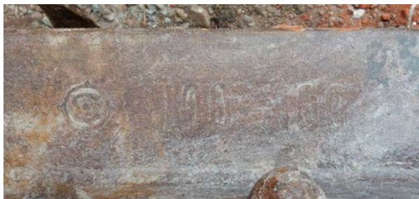
写真-4 柱のロールマーク
