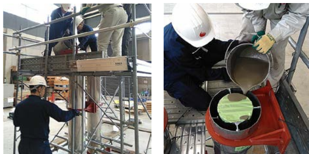
図-2 モルタルの施工状況
