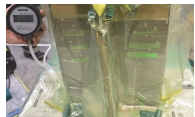
(f) 副資材の設置
