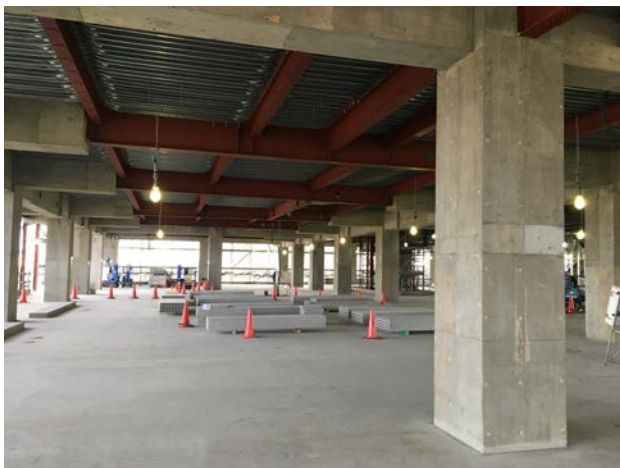
写真-3 支保工除去後の構造部材の様子
