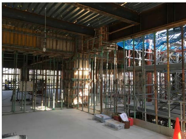
写真-2 施工中の支保工設置状況
