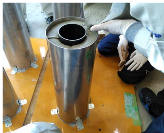
図-2 高流動ゴムラテックスモルタル施工状況
