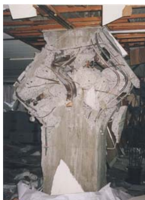
(b) 格子形 SRC 部材のせん断破壊
