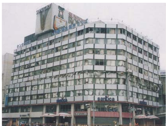
(a) 中間層崩壊した SRC 建築構造物
