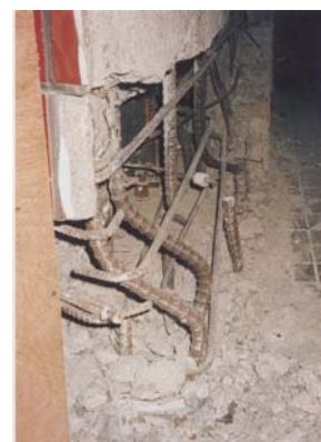
(c) 非埋込み型柱脚の被害
