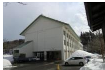
写真1 対象建物外観
