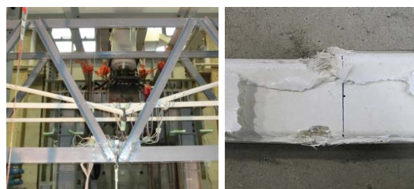
(c) 水平材の脱落 (d) 水平材の破壊状況
