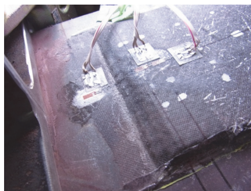
図-16 VaRTM成形されたHFRP板の端部の状況
