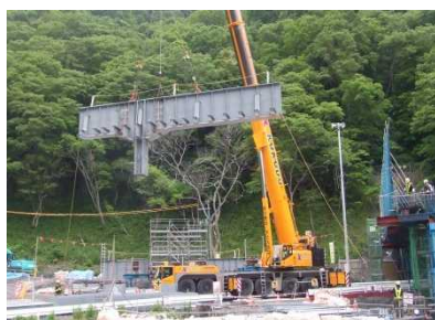
写真-3 鋼桁の架設状況
