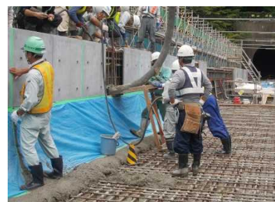
写真-5 桁コンクリート工
