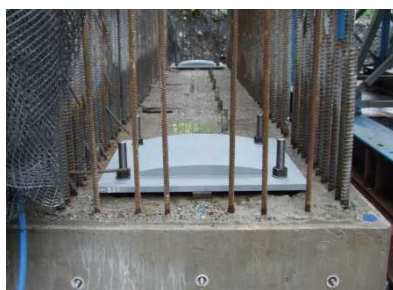
写真-4 鋼製仮支承（下沓）
