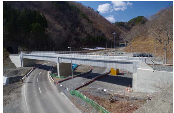
写真-1 新設したハイペ沢桥梁
