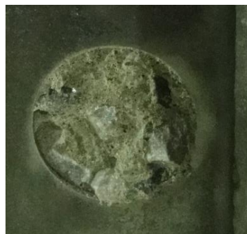
図-14 孔部コンクリートの破壊形状 (側圧がない場合)
