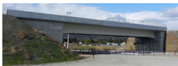
写真-2 鋼ポータルラーメン橋
