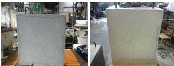
写真-5 φ65(-R)供試体のコンクリートブロックひび割れ
