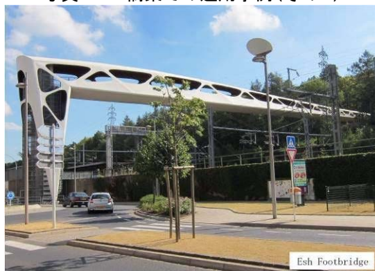
写真-2 橋梁での適用事例(その 2)
