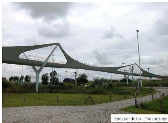
写真-1 橋梁での適用事例(その 1)
