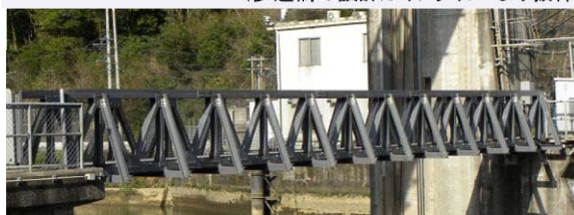
写真-4 ポニートラス構造の FRP 歩道橋
