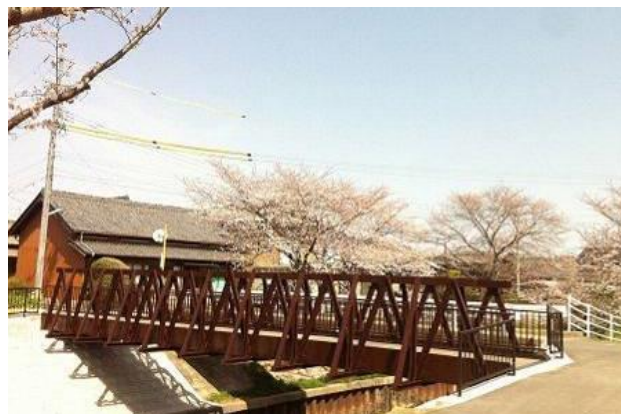
図-1 玄若橋（FRP歩道橋）
