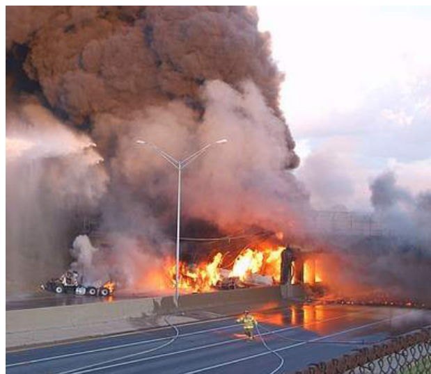
写真-1 9マイル跨道橋直下での橋梁火災
