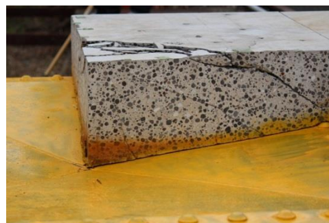
写真-2 破壊断面
