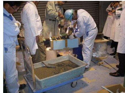
(b) 速硬軽量コンクリート打設状況
