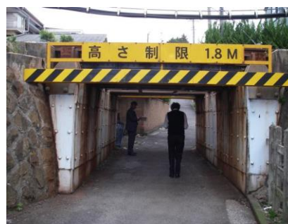
(a) 川島陸橋全景
