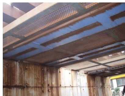
(b) 上り線桁下面（複合構造化前）
