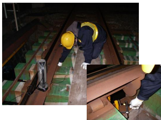
写真-3 ハンマー打撃試験の状況
