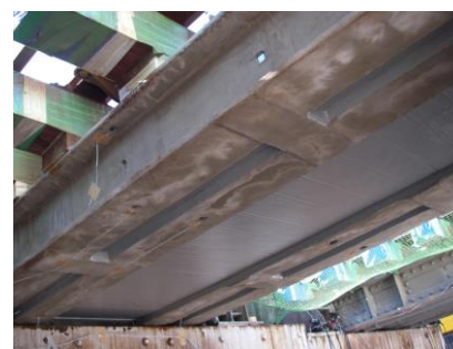
(d) 上り線桁下面（複合構造化後）
