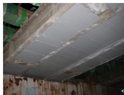
(e) 下り線桁下面（複合構造化後）
