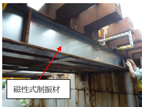
写真-2 磁性式制振材の取り付け状況
