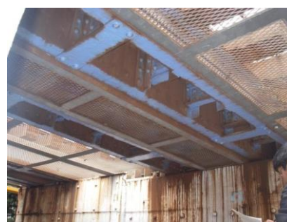
(c) 下り線桁下面（複合構造化前）
