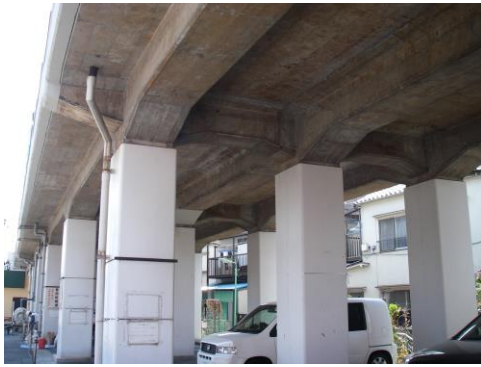
写真-1 RC高架橋の例 (柱部は鋼板巻き補強されている)
