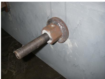
写真-4 PC鋼棒接合部
