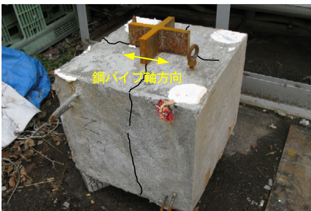
写真-1 コンクリートブロックのひび割れ発生状況
