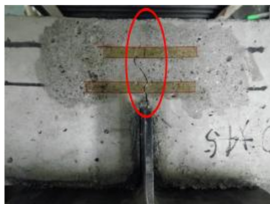
(a) CT 鋼供試体試験後の状態
