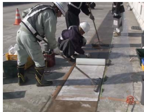
写真7. ガラス繊維シート施工状況
