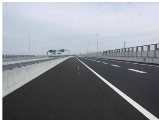
写真9.開通して1年経過したつくば高架橋
