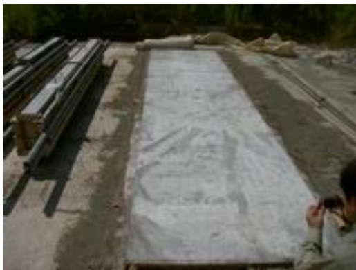
写真1 2010年改良配合による試験施工
