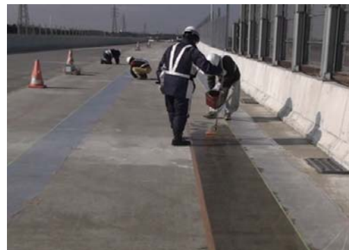
写真6. プライマー施工状況
