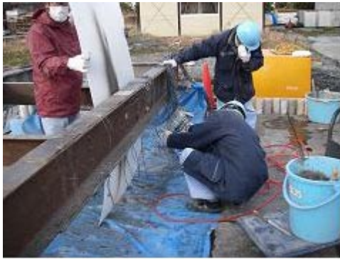
写真-2 ゴムラテックスモルタル吹き付け状況 (飛散対策を行っている)
