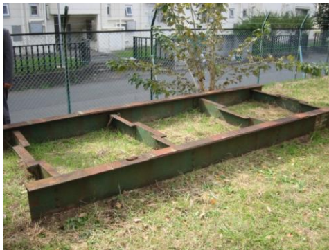
写真-1 試験桁の写真(撤去後)
