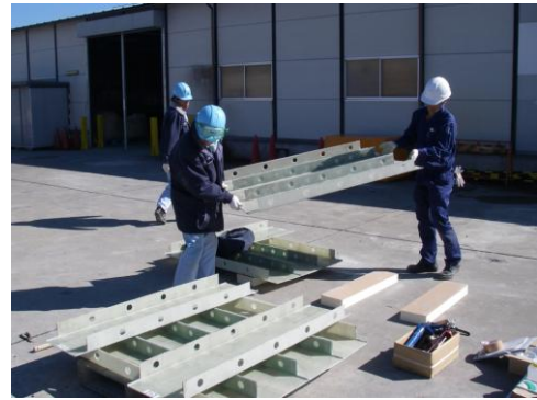
写真-3 GFRP 型枠の運搬状況
