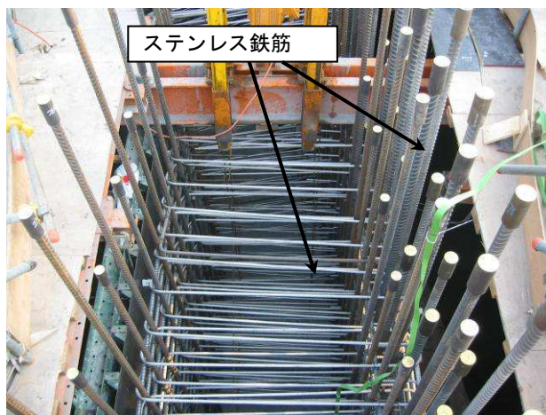
図-5 ステンレス鉄筋
