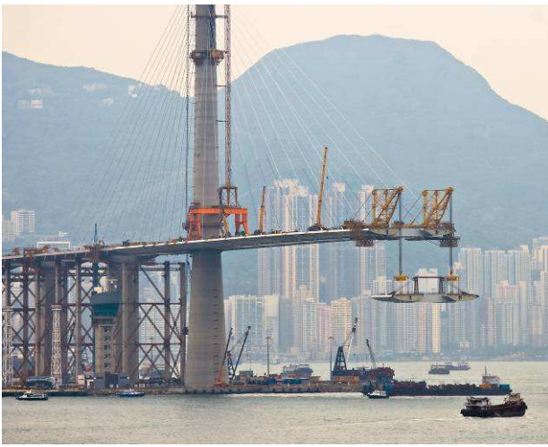
図-9 鋼桁架設
