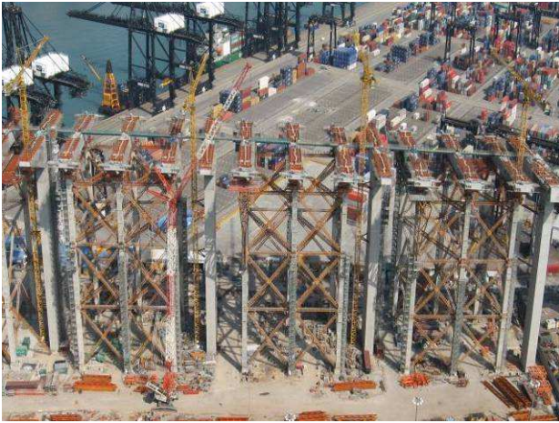
図-7 側径間支保工
