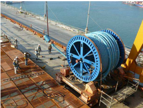
図-10 斜材架設
