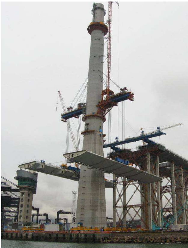
図-8 側径間へビーリフト工法
