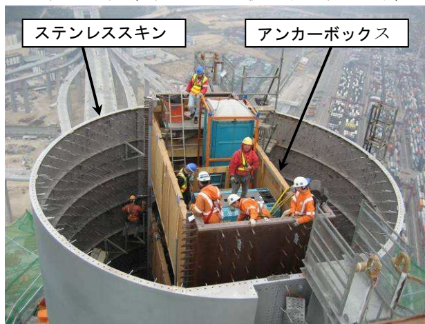
図-6 ステンレススキン・アンカーボックス
