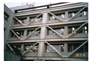
写真3 外付けK型ブレース
