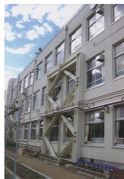
写真2 外付けダイヤ型 ブレース
