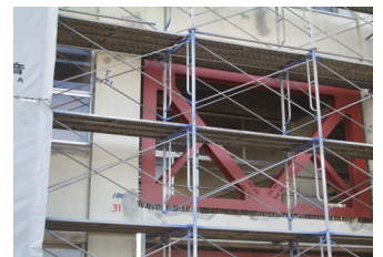
写真1 内付けK型ブレース (施工中)
