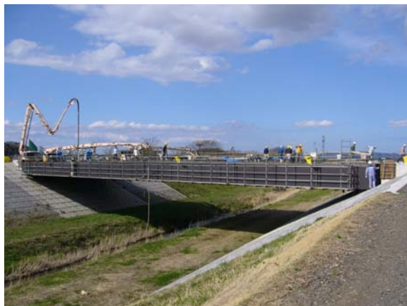
写真6 合成床版橋の全景
