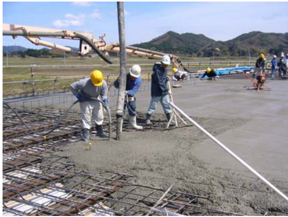
写真4 高性能軽量コンクリートの施工状況
