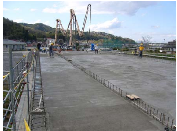
写真5 高性能軽量コンクリートの打込み完了
