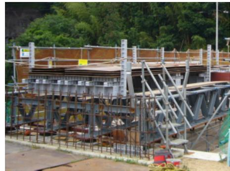
写真-4 敷鉄板の設置による打設シミュレーション状況
