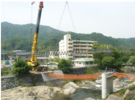
写真-2 A1-P1間の鋼桁架設の状況
