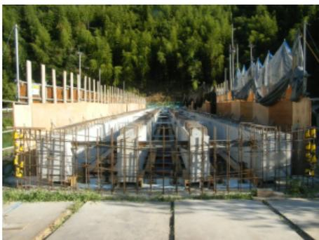
写真-5 横支持装置および型枠撤去後のRCウェブの状況
