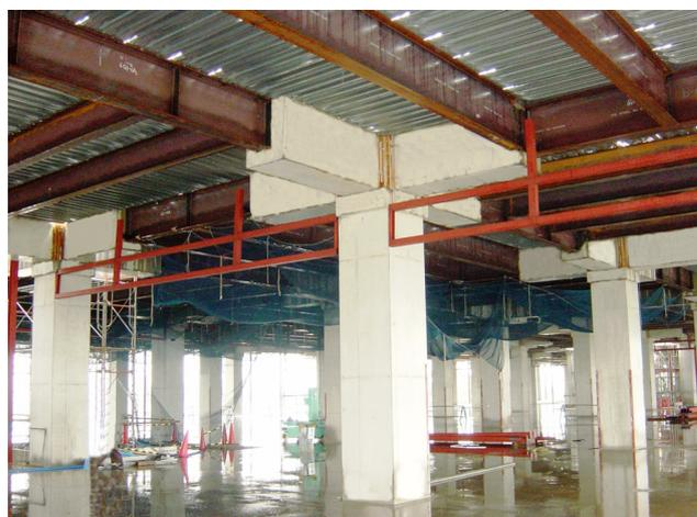
図-1 材端部RC造中央部S造で構成される複合構造梁
