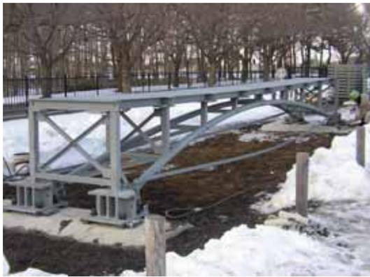
写真-6 単径間設置完了
