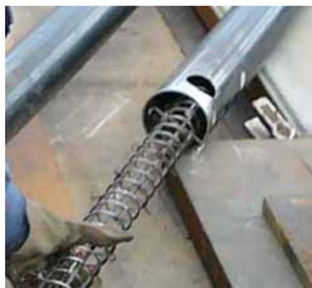
写真-3 内部鉄筋施工状況
