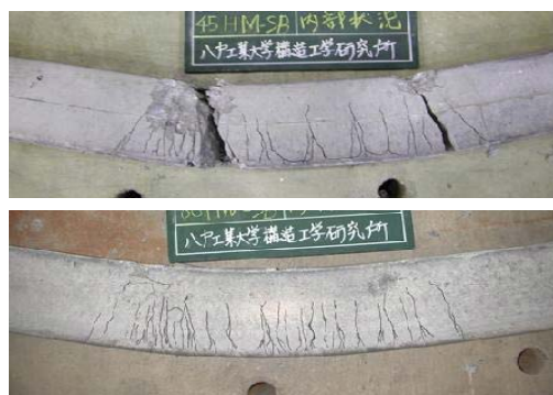
図-12 角形鋼管試験体、充填コンクリート破壊状況：上が CFT (45HM-SB), 下が RCFT (60HW-SB)
