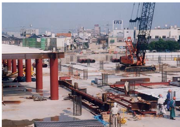
図-7 RCST 構造の建設状況（福山市にて）
