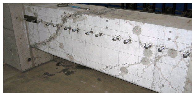
写真 2 ひび割れ補修, 樹脂アンカー施工後
