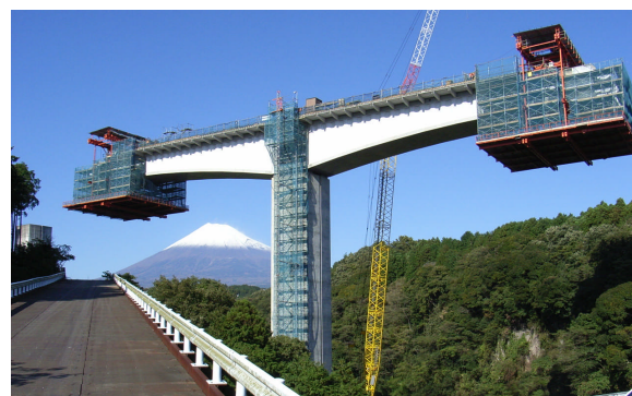
写真-4 張出し施工状況
