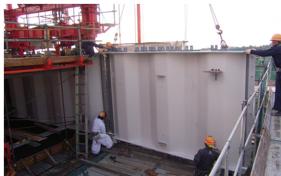
写真-2 波形鋼板先行架設
