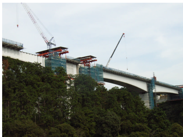
写真-7 P9張出し施工
