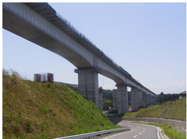
写真-1 赤淵川橋(2007年3月撮影)
