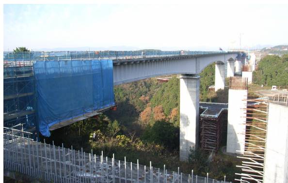
写真-8 P10-A2 側径間施工
