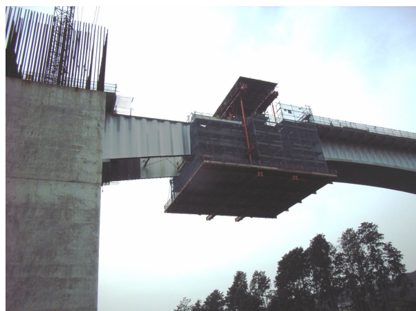
写真-6 P8-P9波形鋼板閉合
