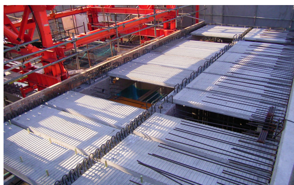
写真-3 プレカストリブ・PC板配置
