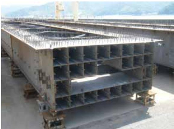
写真-1 鋼殻セル（仮組立状況）
