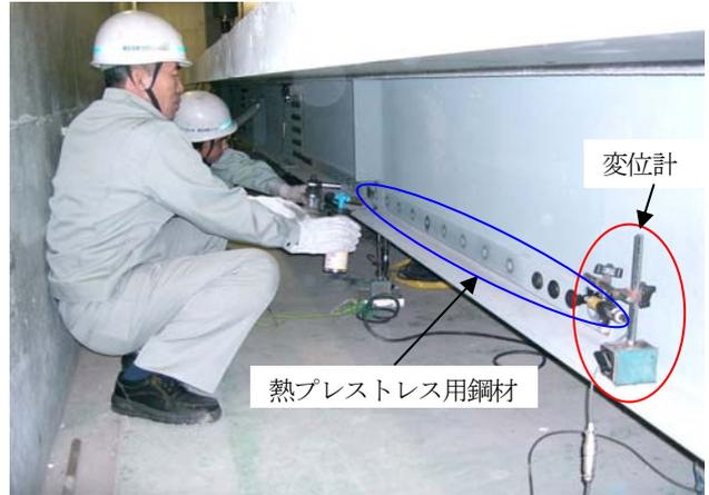
写真-1 熱プレストレス導入状況
