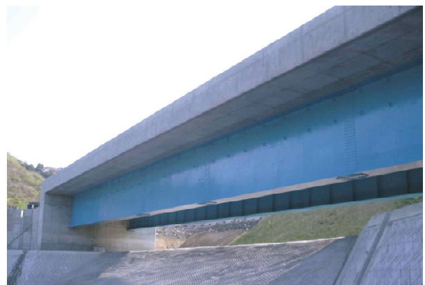
写真-1 阪和自動車道 下谷池橋
