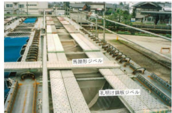
写真-8 完全合成：ジベル配置（馬蹄形ジベルと孔明け鋼板ジベル）
