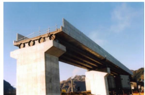
写真-4 充填鋼管複合桁・完成(北陸道架道橋の例)
