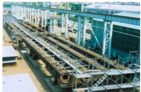
写真-3 充填鋼管複合桁・工場仮組み(北陸道架道橋の例)
