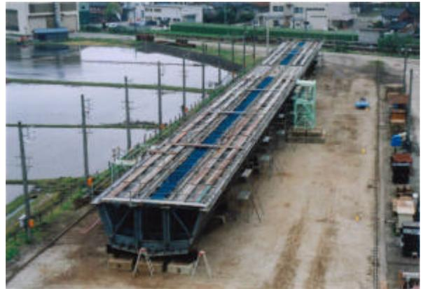
写真-7 ダブル合成桁：工場仮組み（北陸道架道橋の例）
