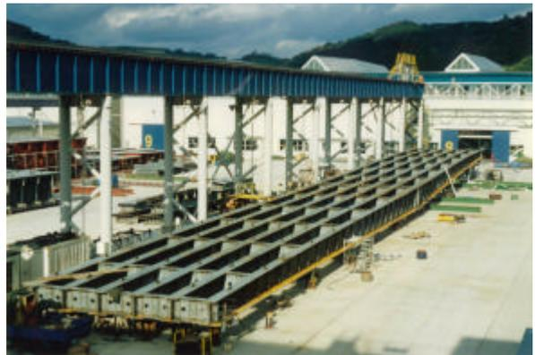
写真-1 マルチT形断面SRC桁：工場仮組み（裾花川橋梁の例）
