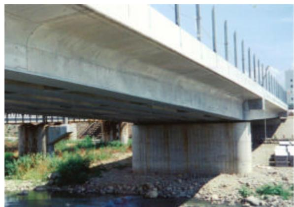
写真-2 マルチT形断面SRC桁：完成（裾花川橋梁の例）
