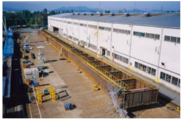
写真-9 合成少数桁：仮組み
