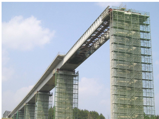
図-16 架設中の波形鋼板手延べ桁
